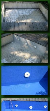
Für die Sanierung des GfK-Fliesenpools wurde das DeinTeich.de <u>Premium-Set</u> mit Epoxidharz für die Grundierung und die Deckschicht genutzt.
