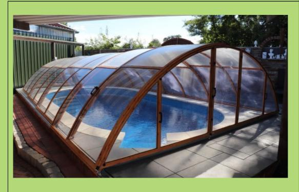
Bei diesem überdachten GfK-Pool wurde mit dem DeinTeich.de Premium-PLUS Set mit Epoxidharz, Glasfasergelege und Polyurethan-Decklack gearbeitet.
