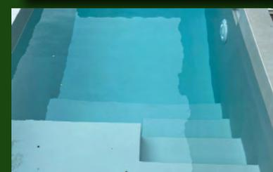
Bei diesem GfK-Tauchbecken wurde mit dem [DeinTeich.de Premium-PLUS Set](#) mit Epoxidharz, Glasfasergelege und Polyurethan-Decklack gearbeitet.
